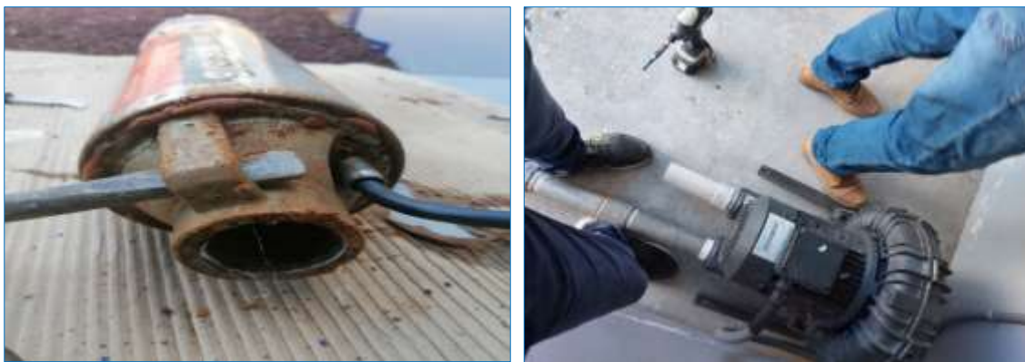
Ilustración 98. Mantenimiento a bombas de planta tratadora y cisternas de la institución.
