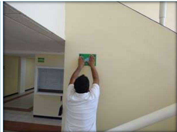
Ilustración 85. Colocación de señalética de rutas de evacuación, salidas de emergencia y precaución.
