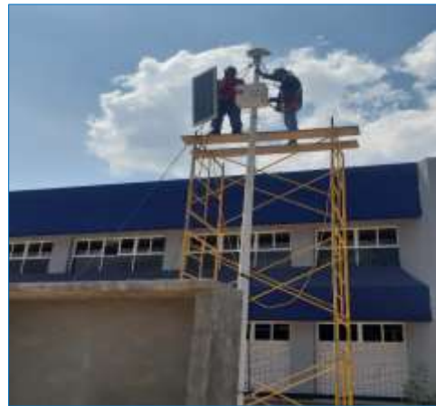
Ilustración 87. Instalación de luminarias led para rehabilitar el alumbrado de la institución.
