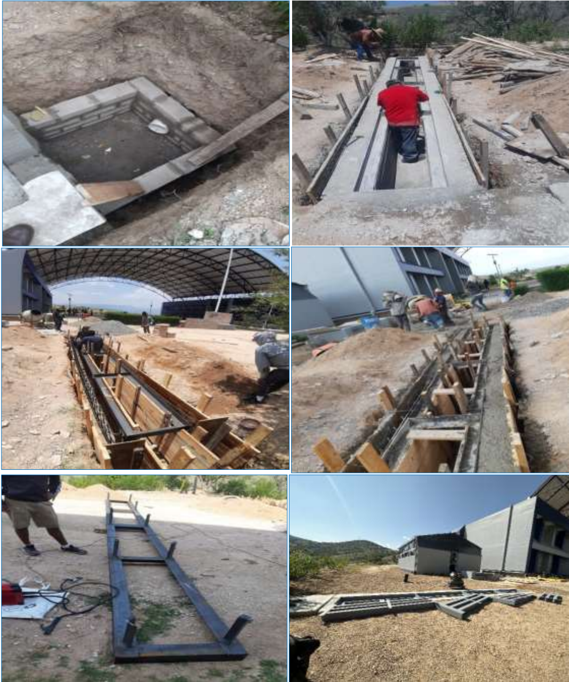
Ilustración 91. Construcción de pichancha a base de muros de concreto armado y rejilla de alta resistencia para tráfico pesado.
