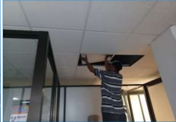
Ilustración 99. Sustitución de luminarias interiores por tecnología led.
