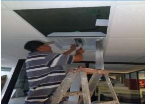
Ilustración 99. Sustitución de luminarias interiores por tecnología led.
