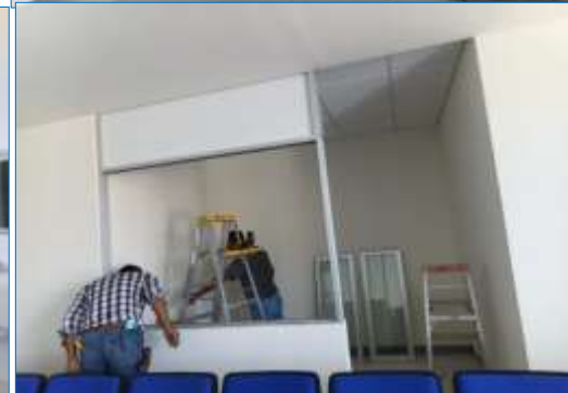
Ilustración 103. Elaboración e instalación de puertas y ventanas en cabina en sala audiovisual, sanitarios de área administrativa y cubículo de centro de cómputo a base de cancelería de aluminio en edificio multifuncional.
