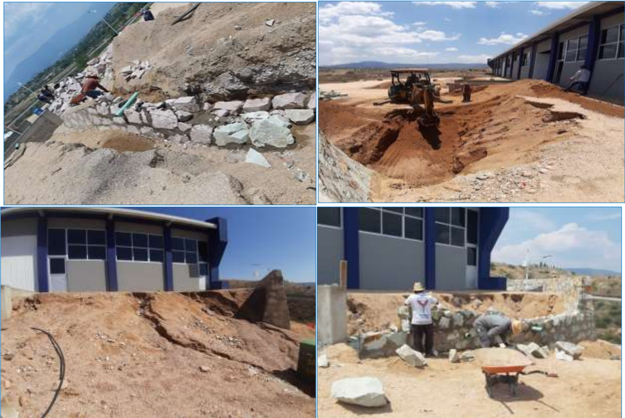
Ilustración 90. Rehabilitación y construcción de muros de contención.
