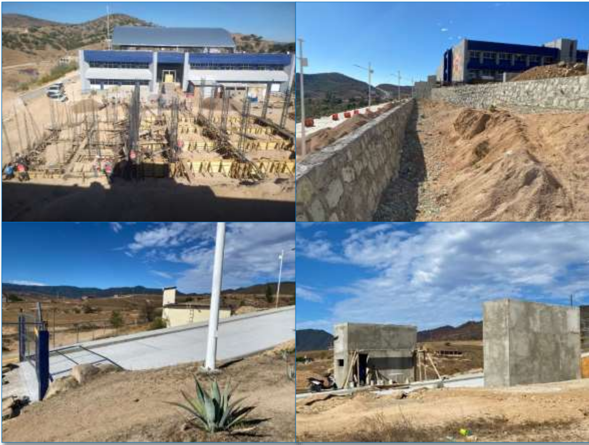
Ilustración 58. Obras en proceso de construcción FAM 2023.
