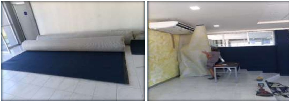
Ilustración 97. Adquisición e instalación de alfombra para sala audiovisual.
