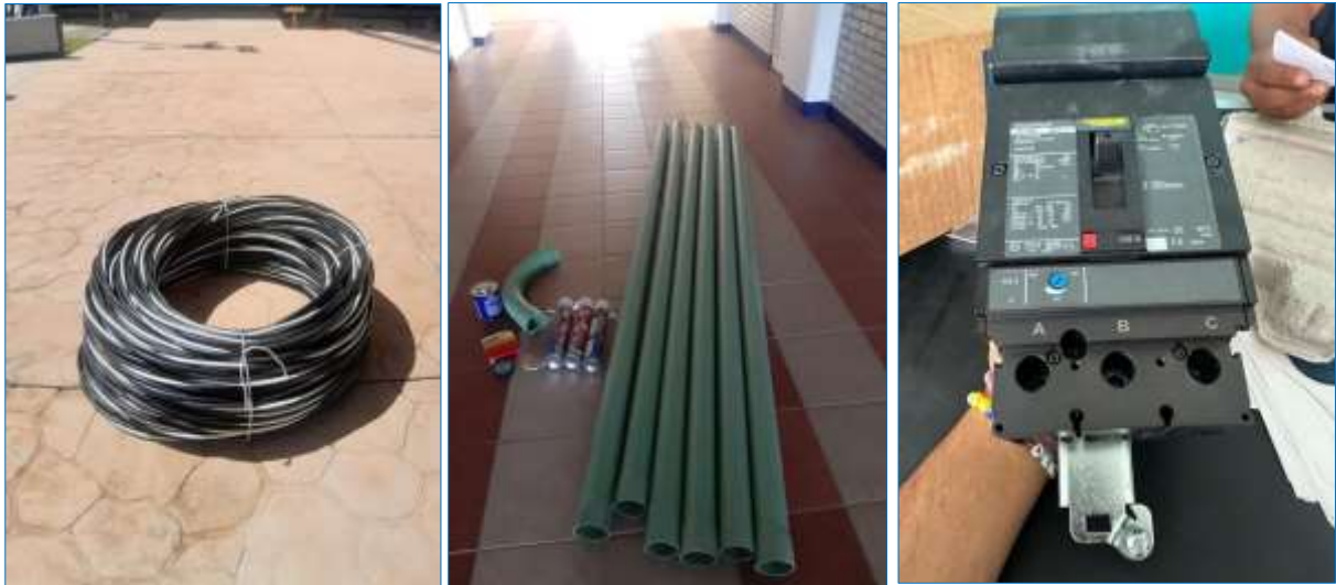
Ilustración 92. Instalación de interruptor termomagnético de 150 amp para el laboratorio de química.
