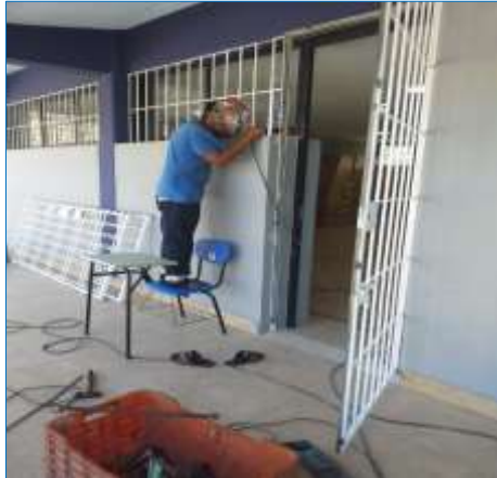
Ilustración 102. Elaboración y colocación de protecciones a base de cancelería en aulas de la unidad de Unión Hidalgo.
