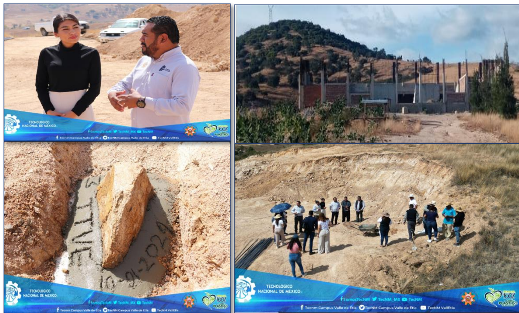
Ilustración 30. Obras realizadas con el recurso beneficiado.
