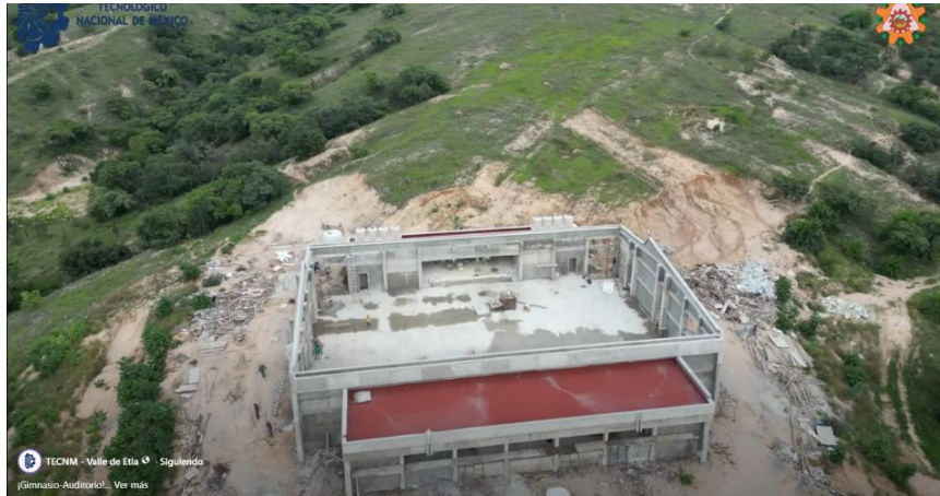
Ilustración 60. construcción del Gimnasio-Auditorio.
